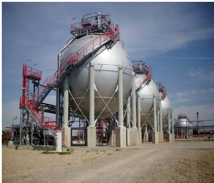
Слика 6. Сфероидни резервоар
