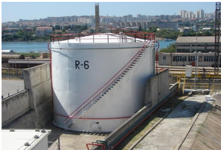
Слика 9. Резервоар са кровом балонске конструкције
