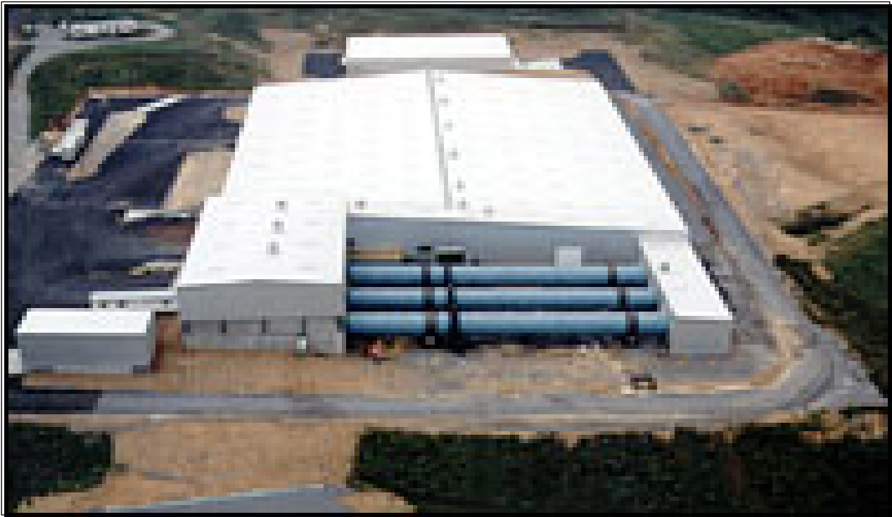
Слика 35. Постројење за компостирање са хоризонталним реакторима [23]
