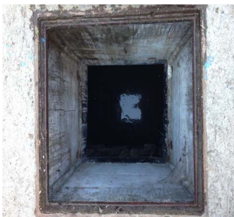
Slika 2. Levi gradski kolektor niškog kanalizacionog sistema [2]
