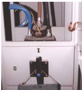
Слика 3. Прекидач на четвртом разводном ормару у погону главног развода 0.4 кV
