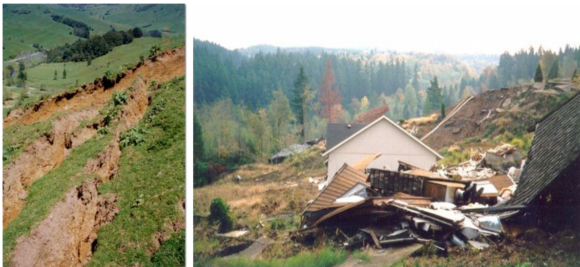
Слика 2. Клизаште на земљиној кори и последице изградне на клизашту
