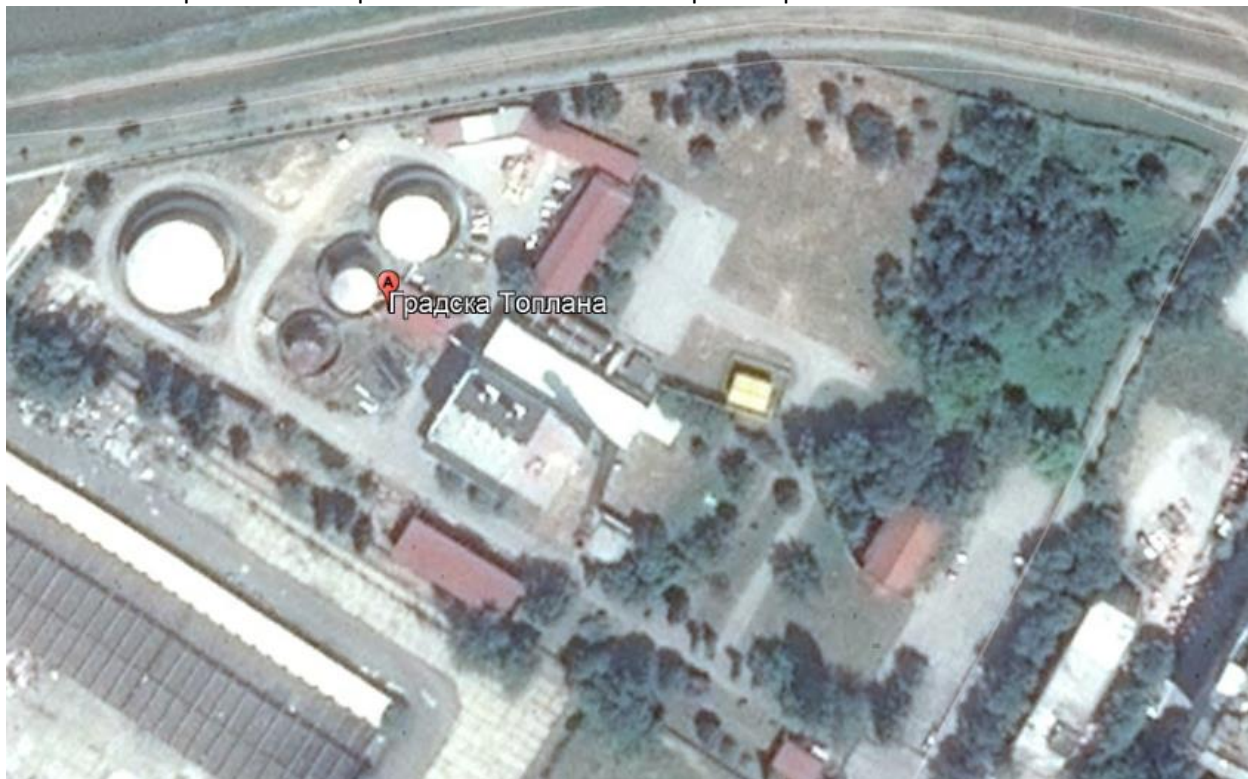
Slika 3.14 Kompleks JKP „Gradska toplana“ ad. Niš – toplana u ul. Blagoja Parovića 3
